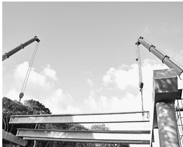
DER-PB inicia a colocação de 30 vigas nesta nova etapa
